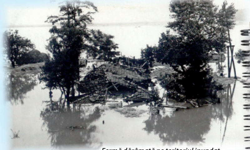
Fermă dărâmată pe teritoriul inundat
