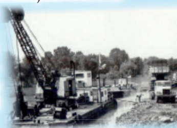
Construirea barajului circular de lângă lunca inundabilă la ruperea terasamentului
