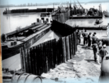
Închiderea temporară a rupturii de pe terasament la ruptura terasamentului
