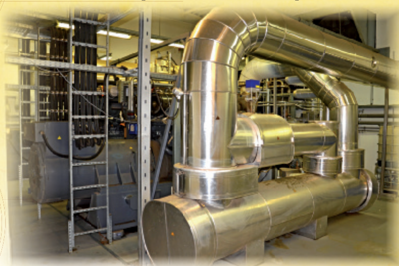
Clădire tehnică: în față se află instalația de recuperare a căldurii din gaze de ardere, în spate se află motoarele de gaz
