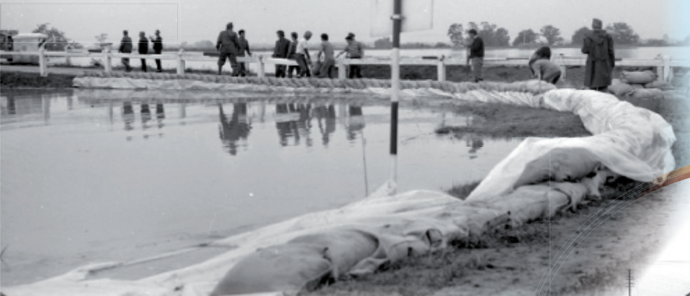
Înălțarea terasamentului la podul de pe Crișul Negru
