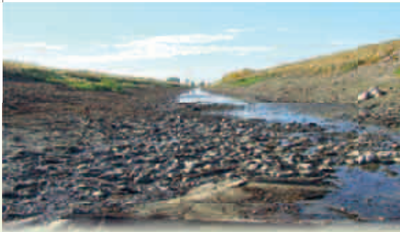
Patul canalului drenat la granița localității Kamut
