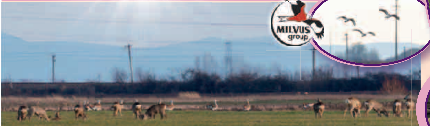
Linii electrice aeriene de medie tensiune la Salonta, în apropiere de habitatul dropiilor
